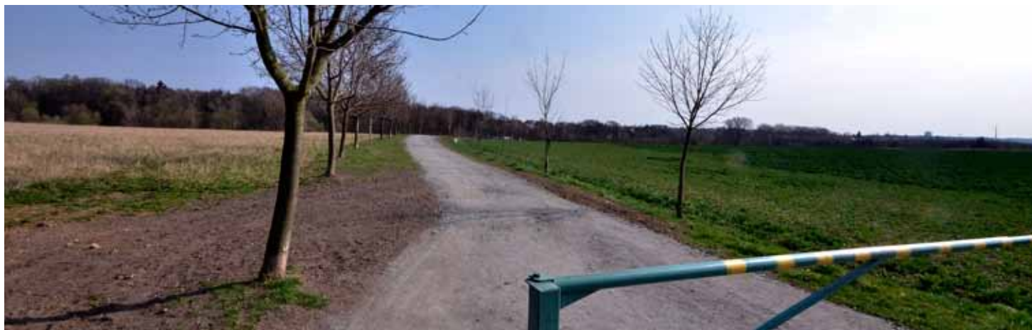
Na přelomu loňského a letošního roku byla provedena výměna vodovodního potrubí na polní cestě mezi Benicemi a Kolo- vraty, tato oblíbená turistická stezka nyní dostala nový povrch.
